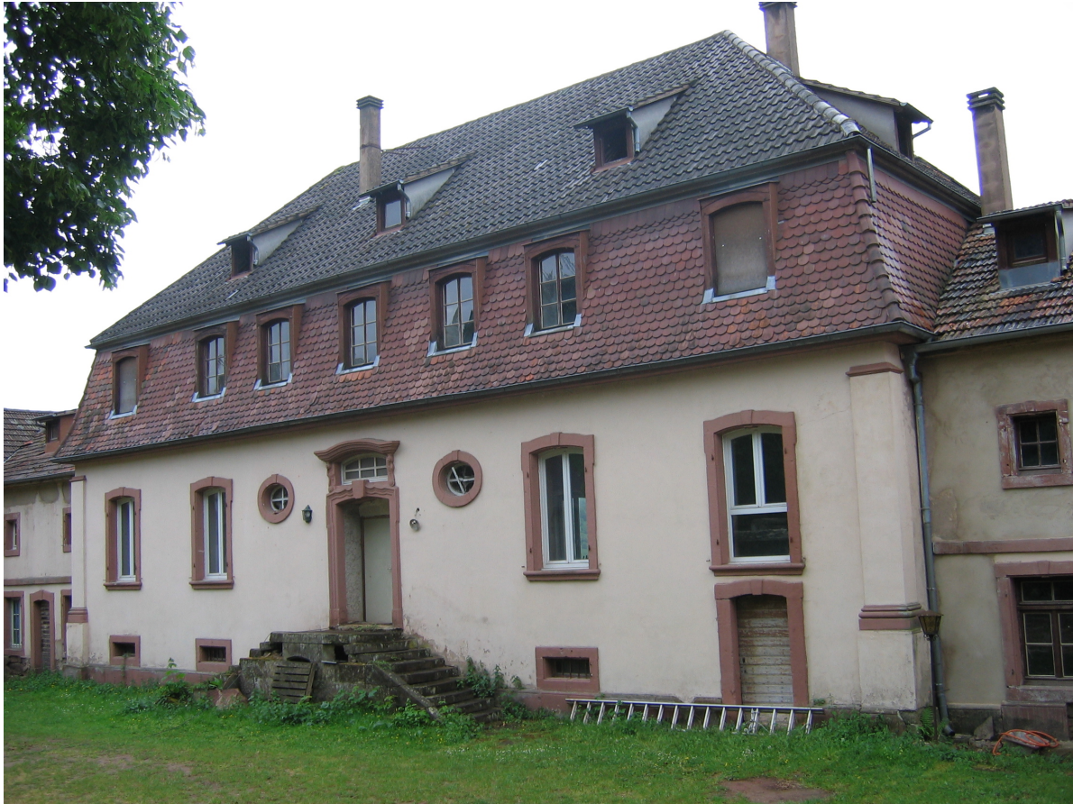
Le château du Langenberg, état actuel
